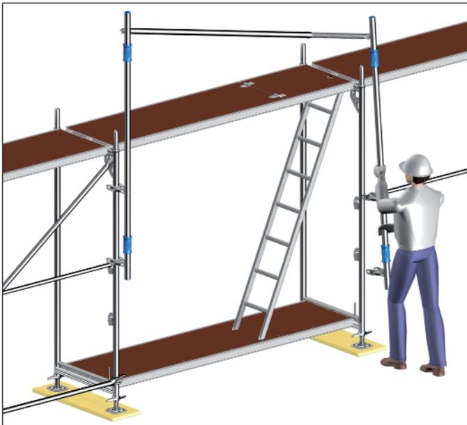
Bild 15: Detail der Anwendung des MSG im Aufstiegsfeld
