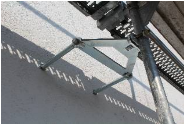
Einfaches und barrierefreies Arbeiten im Gerüst
