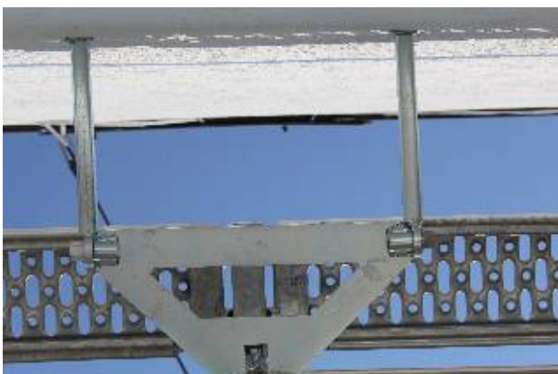
Rahmenabstand von 41/46 und 55 cm für Dämmung 160/200 und 300 cm
