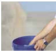
11. Für feste Fremdbeläge wird die Nutzsicht mit Quarzsand abgestreut.
