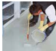
10. Die Nutzsicht Triflex ProTerra wird auf der Fläche aufgebracht.
