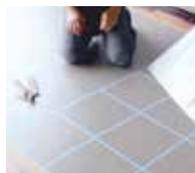
12. Abziehen der oberen Trägerfolie flach und diagonal zum Fugenmuster.
