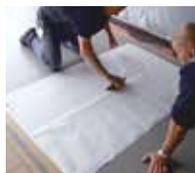
10. Weitere Streifen abziehen (Schritte 7–9) bis die gesamte Folie aufgebracht ist.
