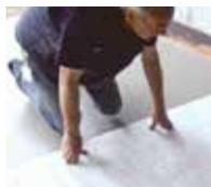
1. Ausrichten der Triflex Design Folie (möglichst an Türen oder Treppenaufgängen anfangen).
