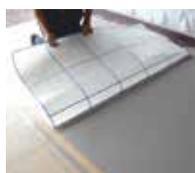
7. Folien über bereits geklebten Rand zurückklappen.
