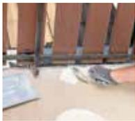
9. Für die Entlüftungseite werden Traufbleche vorbereitet ...
