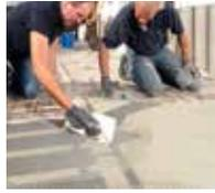
2. Den Armatop MP Kleber mit einer Zahnkelle gleichmäßig auftragen.
