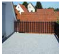
14. Fertig ist die Triflex Stone Design-Fläche.
