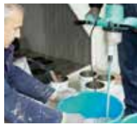
12. Triflex Stone Design S und Triflex Stone Design R mischen ...
