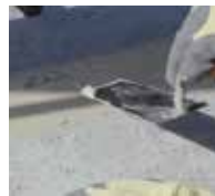
10. Profilschienen mit Triflex Cryl Spachtel einkleben.
