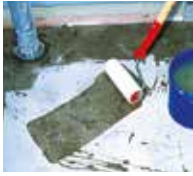
1. Anschlüsse und Fläche grundieren.
