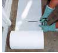
2. Triflex Spezialvlies-zuschnitte vorbereiten.
