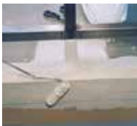
5. Eine zweite Schicht Triflex ProDetail wird aufgebracht.
