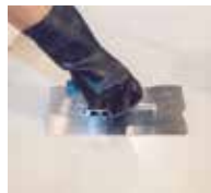
7. Die Beschichtung Triflex ProFloor mit einer Kelle aufziehen, egalisieren ...
