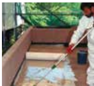
6. Anschließend erfolgt die Flächenabdichtung ...
