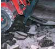
1. Alte Beläge werden entfernt.
