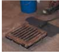
3. An Anschlüssen und Details wird Triflex ProDetail vorgelegt, ...
