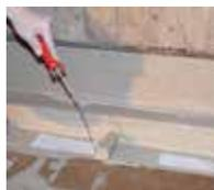
2. Die Details werden mit Triflex Than R 557 thix vliesarmiert abgedichtet.
