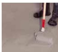
6. Abschließend wird die Fläche mit Triflex Pox Finish 173+ versiegelt.
