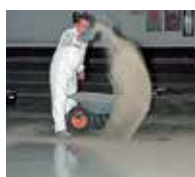
5. Die frische Beschichtung wird mit Quarzsand im Überschuss abgesandet.
