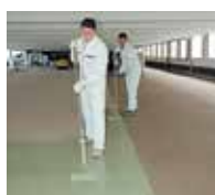
4. Die Beschichtung Triflex Cryl Finish 209 gleichmäßig auftragen.
