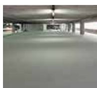
6. Abschließend wird die Fläche mit Triflex Cryl Finish 209 versiegelt.
