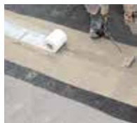
3. ... Fugen werden mit Triflex ProDetail abgedichtet.
