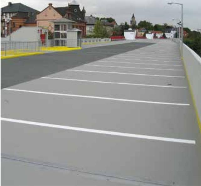
**Triflex ProPark** ist ein vollflächig vliesarmiertes Abdichtungssystem, das auf frei bewitterten Parkdecks und Topdecks eingesetzt wird. Das mechanisch hoch belastbare System aus schnell reaktiven Polymethylmethacrylharzen (PMMA), das speziell für den Parkhausverkehr entwickelt wurde, schützt das Bauwerk langzeitsicher. Das Topdeck Abdichtungssystem Triflex ProPark besitzt ein allgemeines bauaufsichtliches Prüfzeugnis (abP) und ist nach OS 10 klassifiziert.
