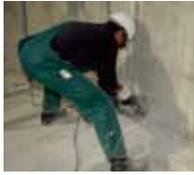
1. Der Betonuntergrund wird angeschliffen, um die Zementschlämme zu entfernen.
