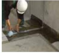
3. Die eingelegte PE-Rundsnur wird mit Triflex Steinklebeband abgeklebt.
