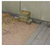
10. Nach 3 Stunden können auf einer Bauschutzmatte weitere Aufbauten folgen.
