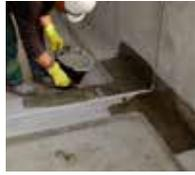
2. Fugenbereiche werden mit Triflex Cryl Primer 276 grundiert.
