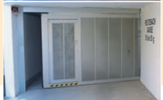
Lochblech-Füllung und Schlupftür im Torflügel integriert
