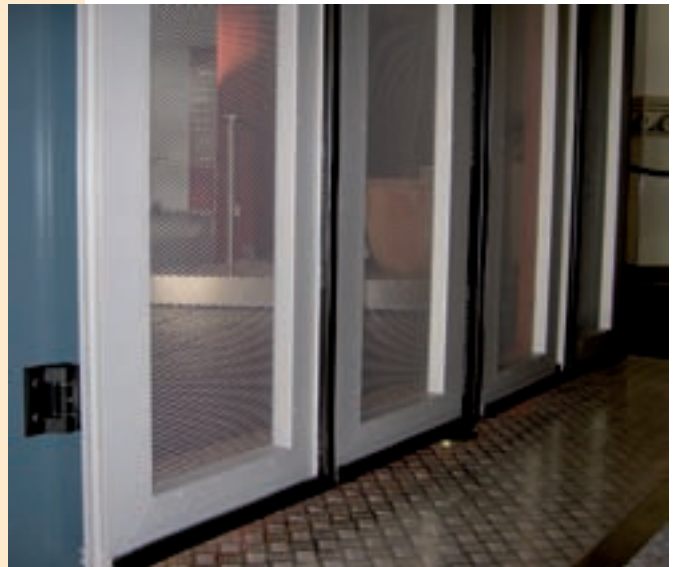
Unfallschutz I: Kontaktleisten auf dem Torflügel sorgen für maximale Sicherheit des Benutzers
