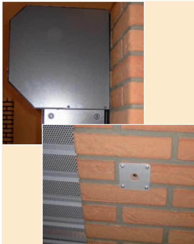
Zwei serienmäßige Highlights: Der solide, form-schöne Blendkasten und die bedienerfreundliche Notöffnung von außen
