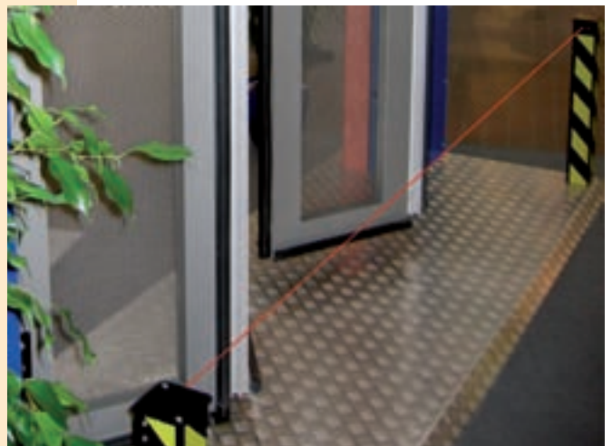
Unfallschutz II: Im Rauminnern sichert eine zweite Lichtschranke den Schwenkbereich ab
