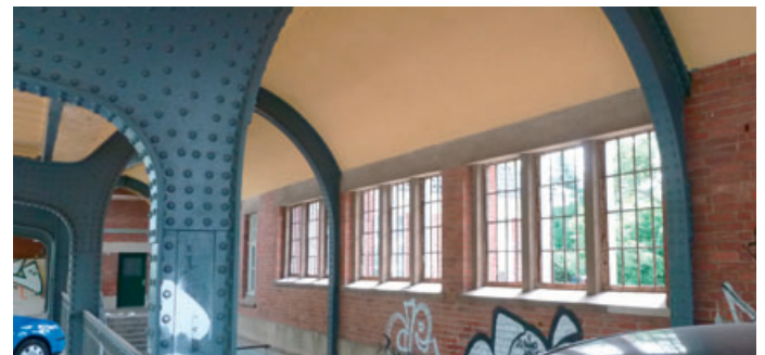
FENSTERÖFFNUNGEN DES ALTEN TRAVEMÜNDER HAFENBAHNHOFES
