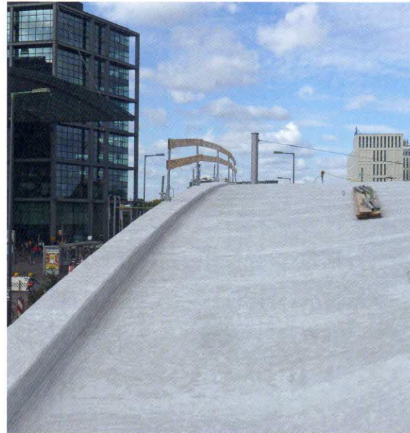
Bild 5. Die Abdichtung ist für das Auftragen des Topsiegels vorbereitet
