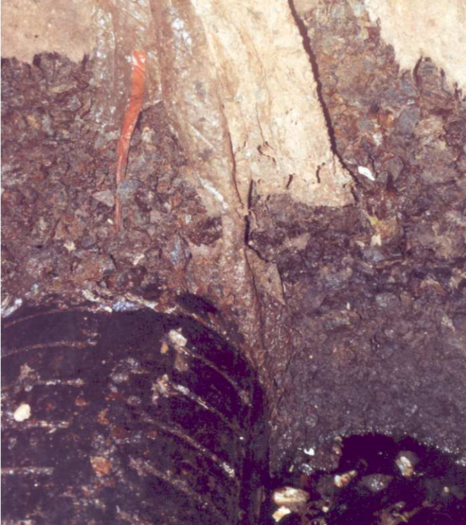
Abb.: 6: Kiesüberdeckung Altrohr vor dem Berstlining
