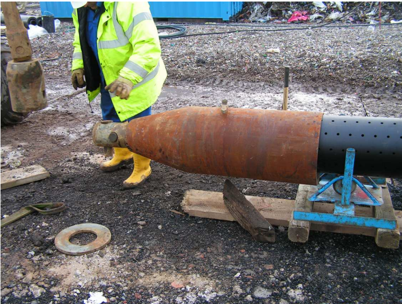
Abb.: 7: Montage des Zug- und Aufweitkopfes
