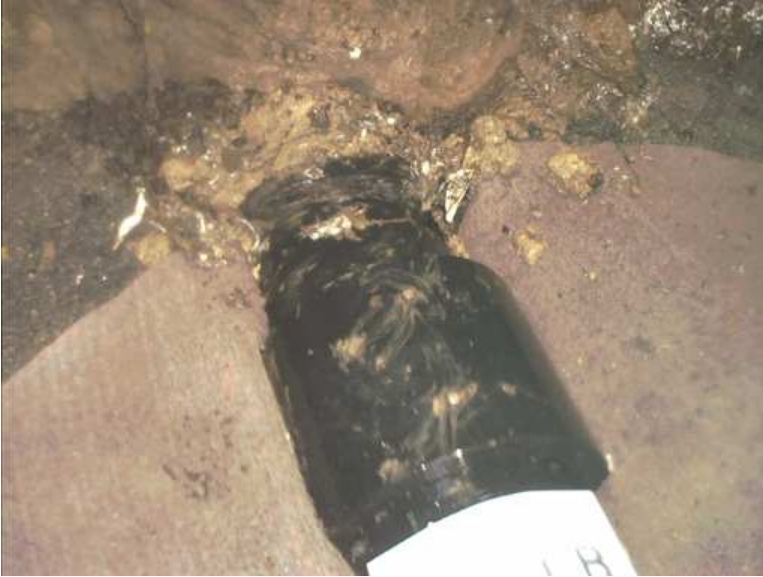
Abb.: 10: Muffenbereich nach dem Berstling
