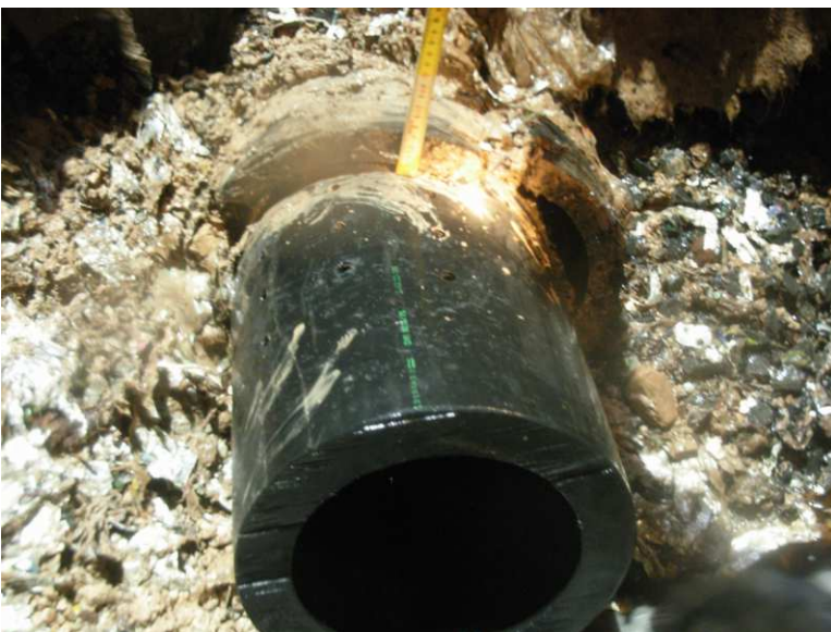
Abb.: 9: Eingezogenes Sanierungsrohr nach dem Berstlining
