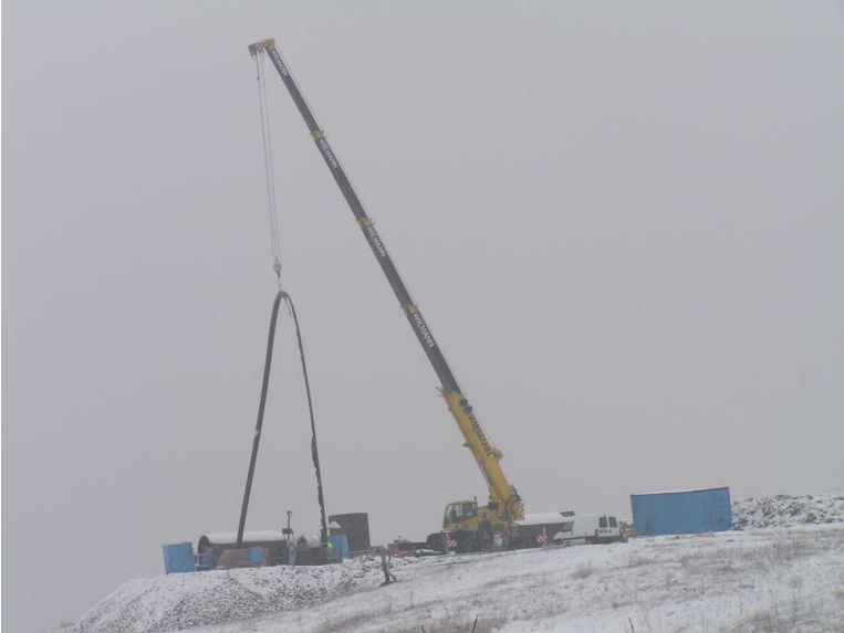
Abb.:8: Bersten der Altrohrleitung, eine Arbeit auch für schlechte Witterung
