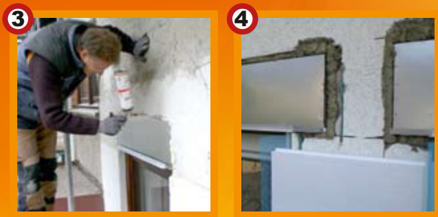
3. Der neue RKS-VWS Rolladen-Kasten wird vor Austausch des Fensters und innerer Abdeckung fertig eingebaut.
